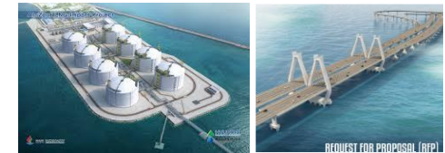
Kuwait Al-Zour LNG
